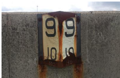
鉄粉の付着による視認性の低下
