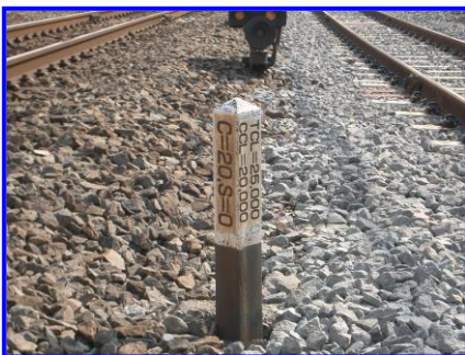
鉄粉の付着による視認性の低下
