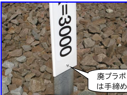
暴風対策はビス穴で固定すればOK
