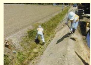
土水路の中に作動油がこぼれたのでオイルゲーターを使用し、早期処理を行い、油分の流出を防いだ。
