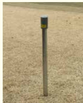
②くい打ち完了
